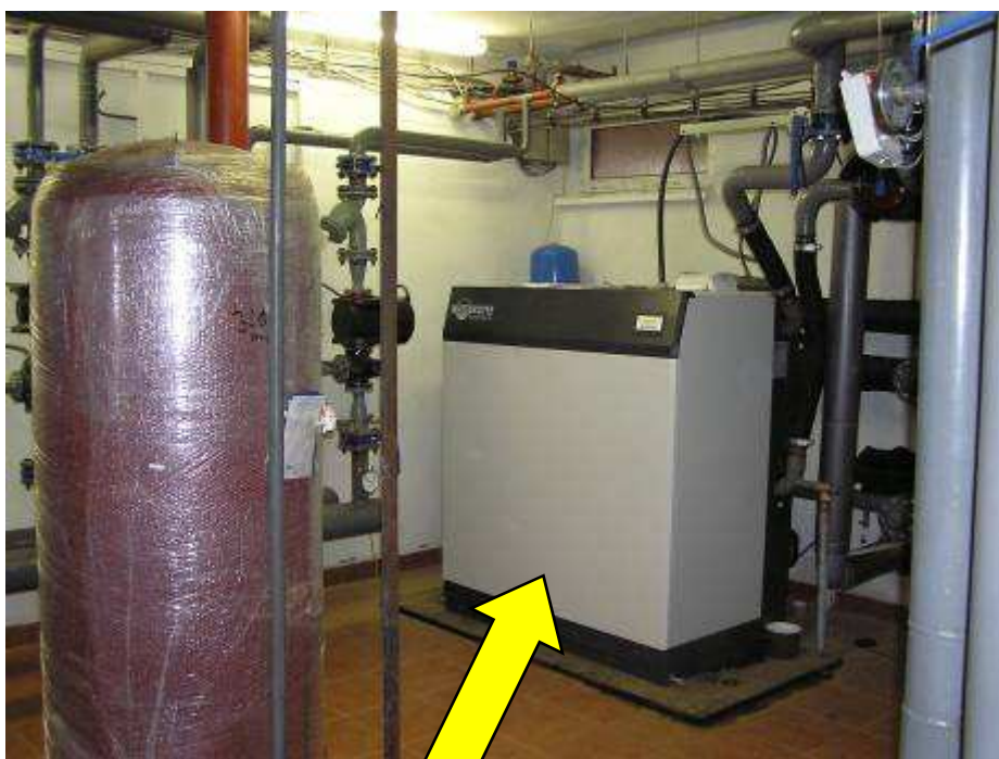
STROJOVŇA S TEPELNÝM ČERPADLOM
