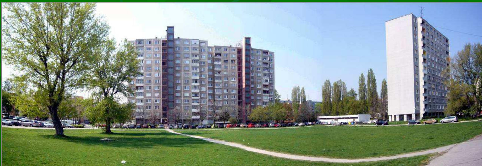
Pohľad na záujmové územie z juhovýchodu
