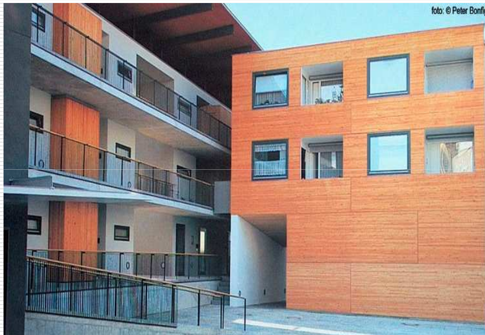
DETAIL FASÁDY, PREKRYTIE PAVLAČE
