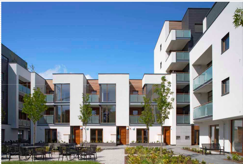
POHĽAD DO JUŽNÉHO NÁDVORIA
