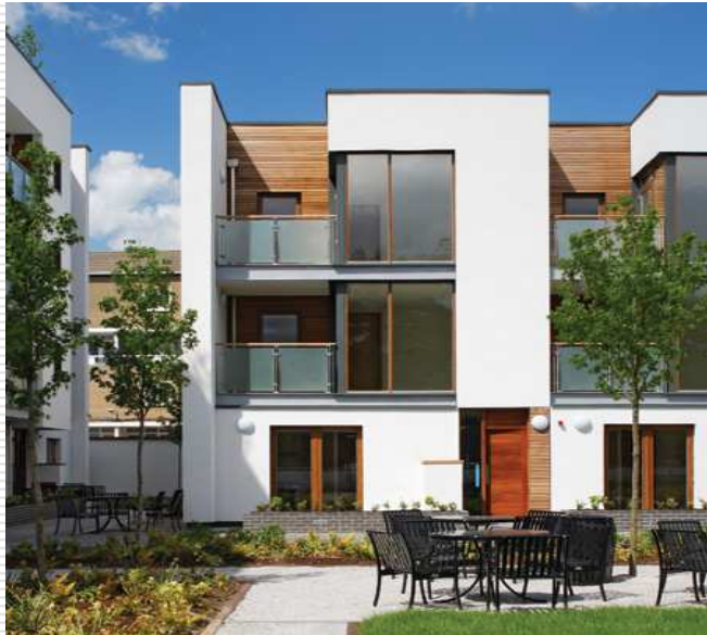
POHĽAD DO NÁDVORIA
