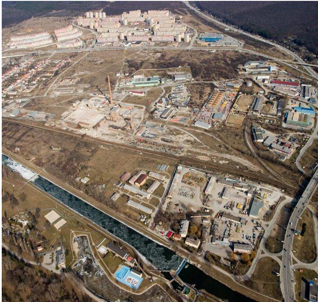
Ťahanovce – Magnezitárska - aktuálny stav
