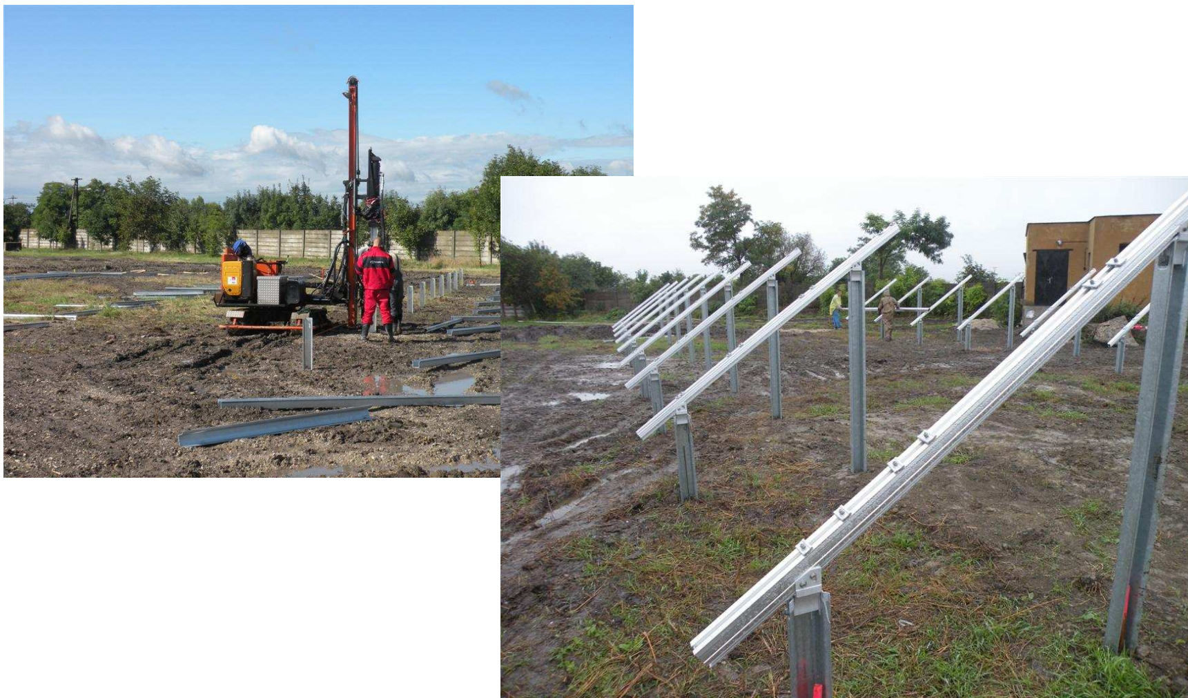
FVE Čakany, inštalovaný výkon 830 kWp
