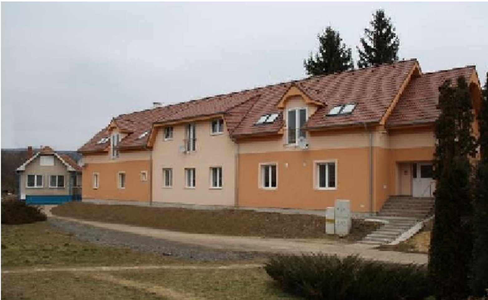
Nová Dedina prestavba materskej školy na domov sociálnych služieb pre dospelých s celodennou prevádzkou a nadstavba 4 bytov
